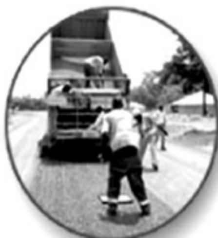
Aménagement de chaussées
